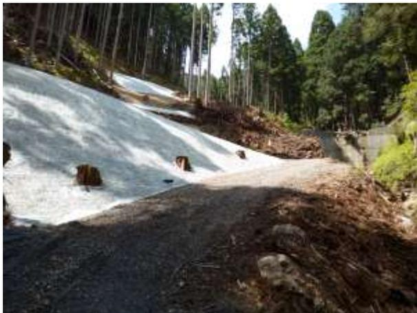
一方、復旧工事も進んでいるようで、左記写真のように、山の斜面にネットが張られていたり、下記写真のように、奥手の林道部分でも擁壁が崩れた箇所は土嚢が積まれたりはしていました。
